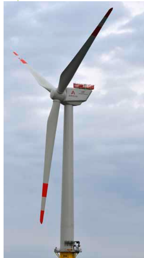
Windenergieanlage der Stadtwerke Fröndenberg im Windpark Borkum: Die beteiligten Stadtwerke tragen aktiv zur Reduzierung des CO 2 -Ausstoßes bei.
