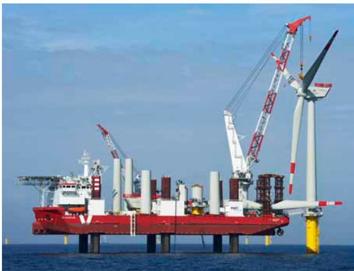
Trianel Windpark Borkum: Im ersten Bauabschnitt wurden 40 Windenergieanlagen mit einer Gesamtleistung von 200 Megawatt errichtet.
