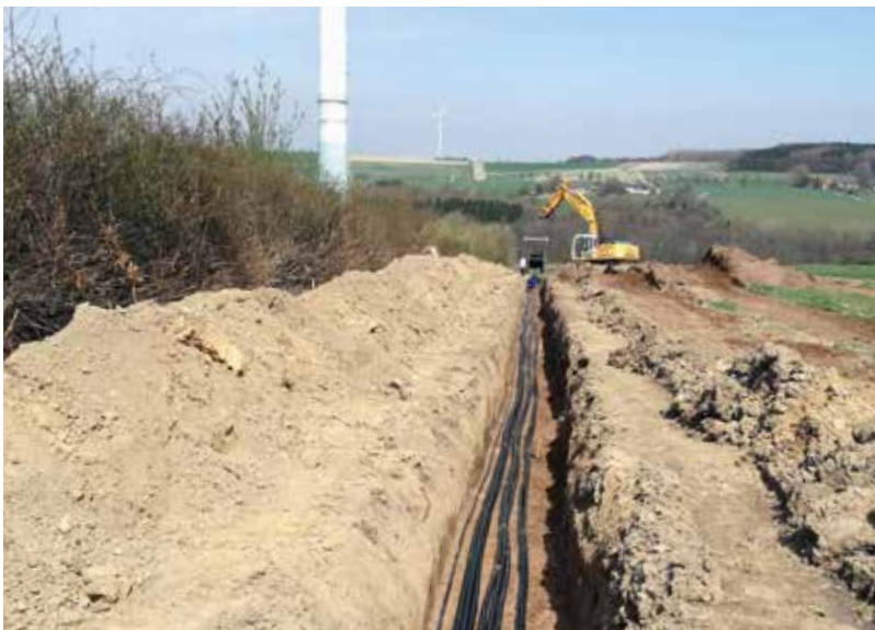
<< Verlegung neuer Mittelspannungsleitungen zwischen Fröndenberg-Mitte und Ostbüren
